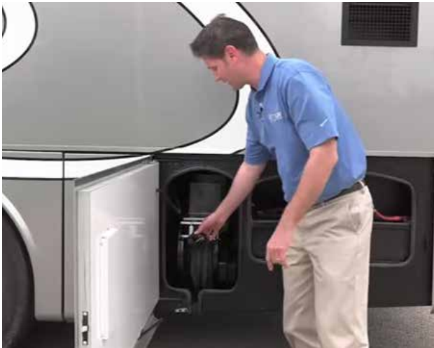
Cordon secteur 50 A sur l'enrouleur électrique.
