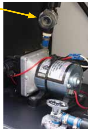
Installation typique de pompe à eau
