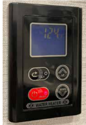
Chauffe-eau sans réservoir Panneau de commande de l'utilisateur (UCP) monté sur une paroi de la salle de bains.
